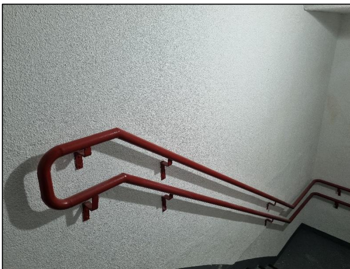
Corrimão duas alturas instalado e Escada de emergência
