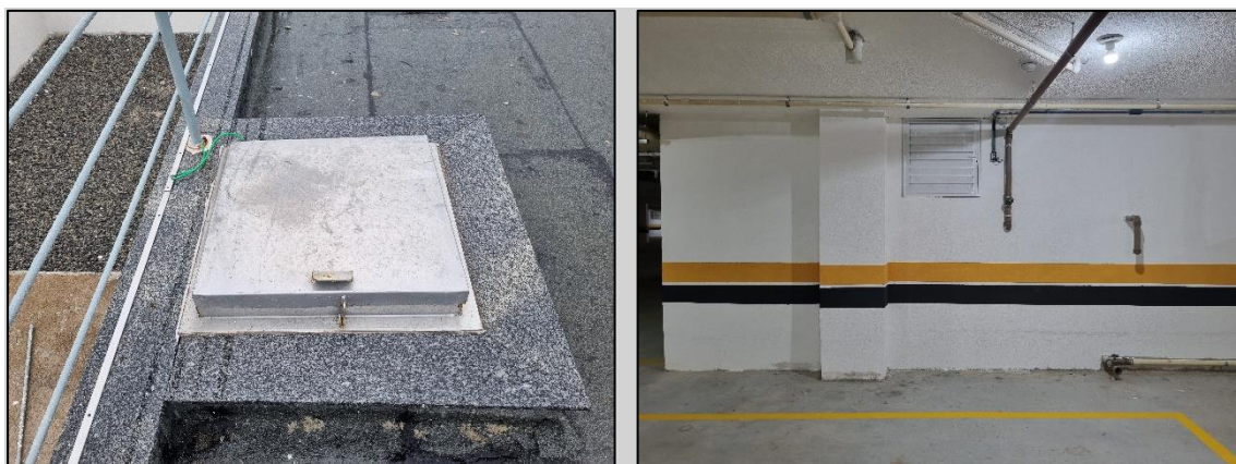
Reservatório Superior e Reservatório inferior
