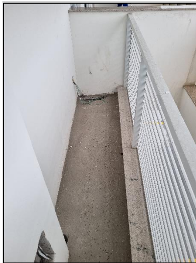
Área técnica para instalação de aparelhos de ar-condicionado
