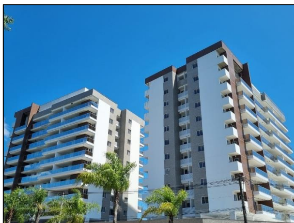
Fachadas da Torres
