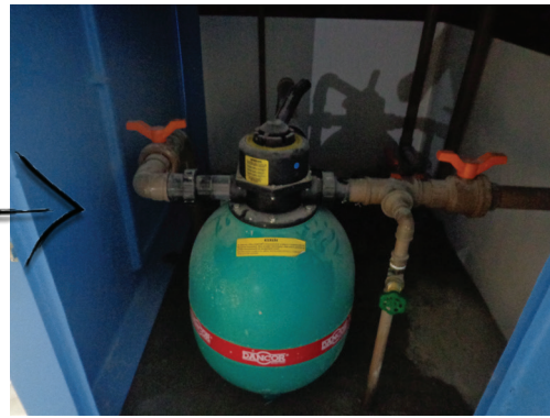
Figura 129 | Bomba e filtro da piscina
