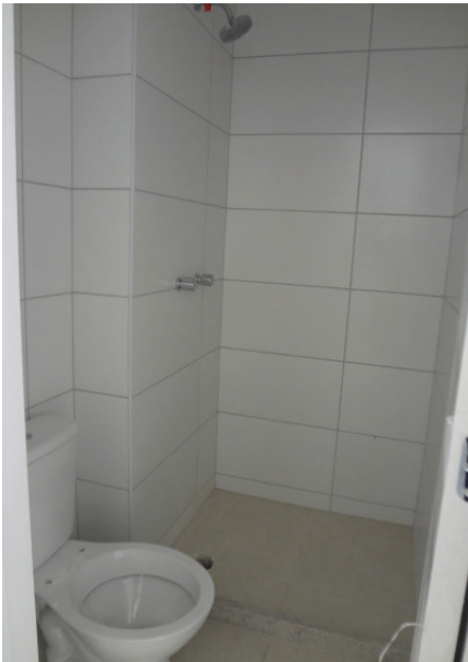
Figura 6 | Revestimento cerâmico nos banheiros das unidades privadas
