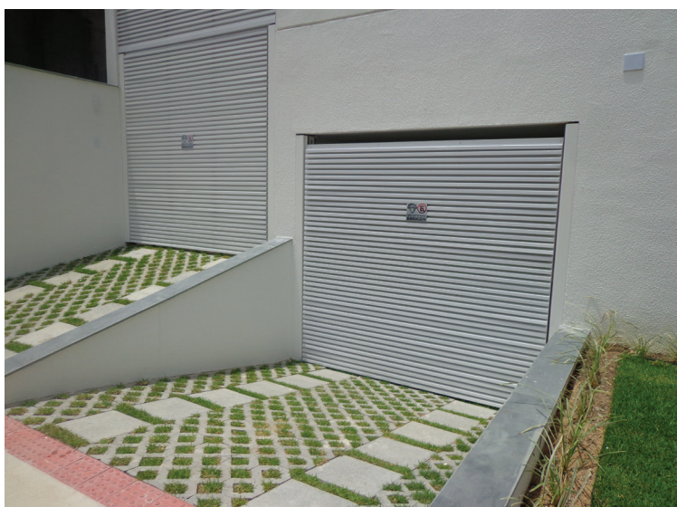
Figura 97 | Portões de abertura basculante de acesso às garagens
