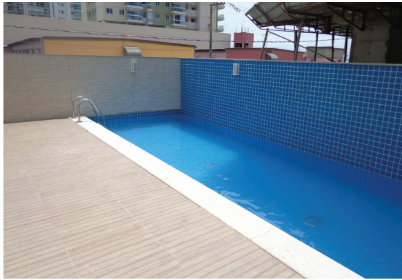
Figura 40 | Impermeabilização no deck e na piscina
