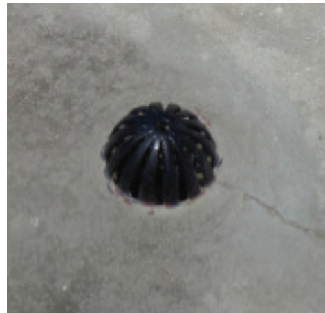
Figura 57 | Ralo abacaxi na laje descoberta na cobertura
