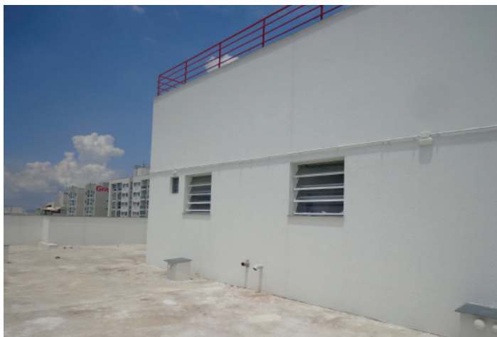
Figura 46 | Reservatório superior em concreto
