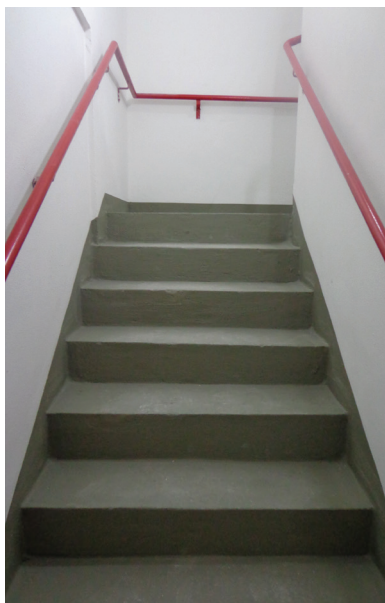
Figura 27 | Corrimão da escada
