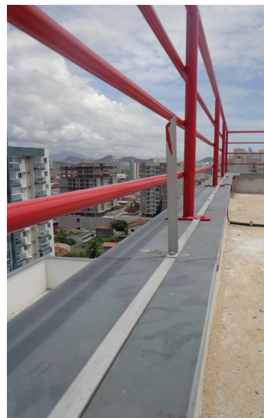
Figura 29 | Guarda corpo na laje de tampa do reservatório superior
