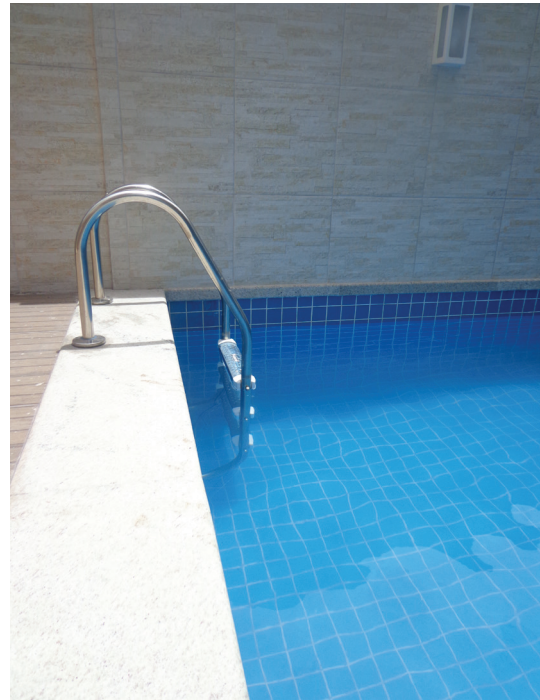
Figura 32 | Escada de acesso a piscina em aço inox
