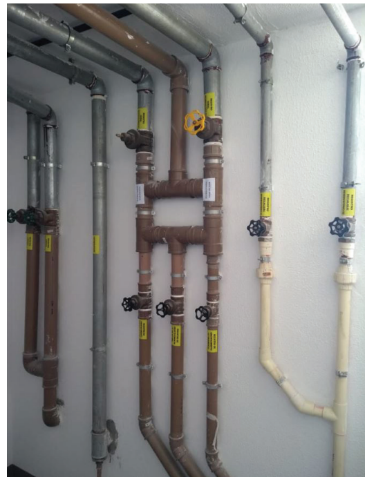
Figura 49 | Barrilete no pavimento telhado
