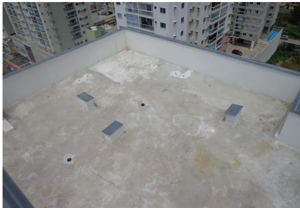
Figura 41 | Laje descoberta da cobertura impermeabilizada
