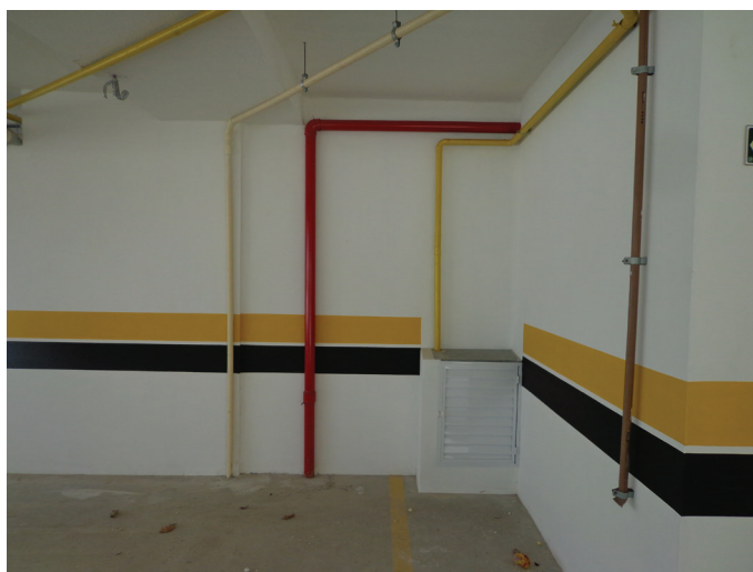
Figura 89 | Abrigo do regulador de 2º estágio na garagem do pavimento lazer
