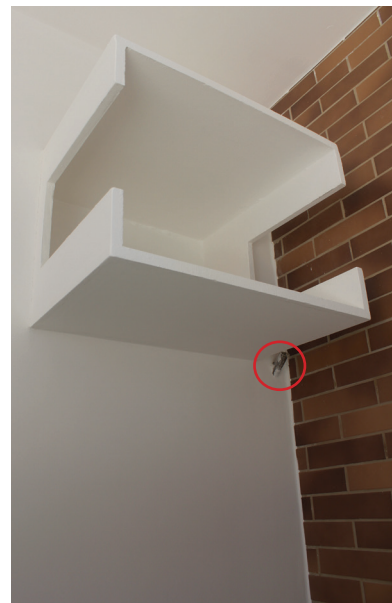
Figura 83 | Detalhe do dreno do ar condicionado
