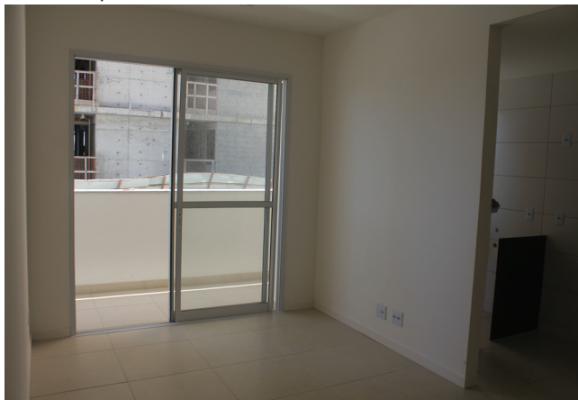
Figura 15 | Pintura aplicada nas paredes internas das unidades privadas
