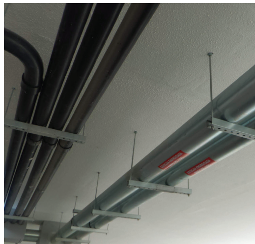
Figura 61 | Detalhe do suporte preso laje do pavimento garagem
