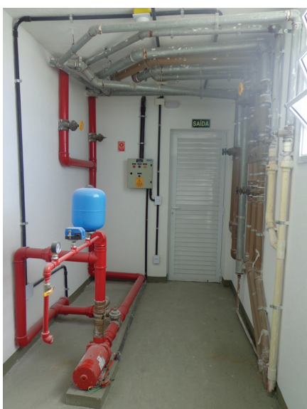
Figura 109 | Bomba do sistema hidráulico preventivo e quadro de comando
