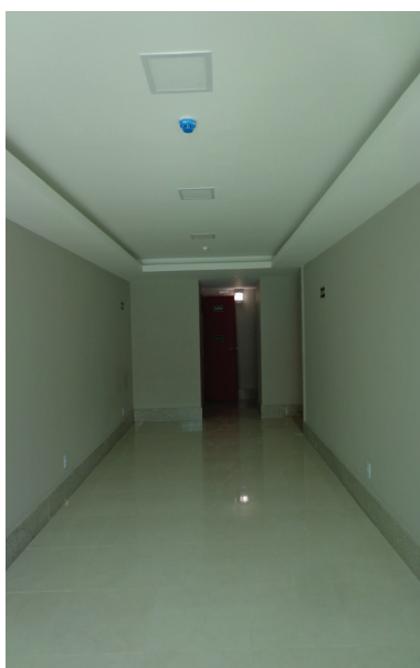
Figura 38 | Rebaixamento em gesso na área comum
