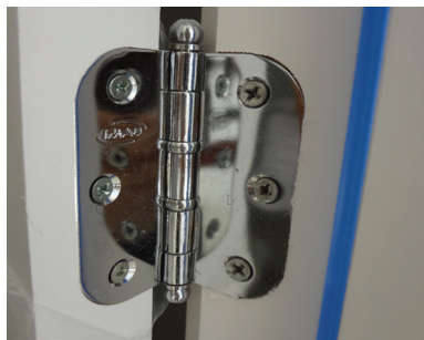
Figura 19 | Dobradiça metálica
