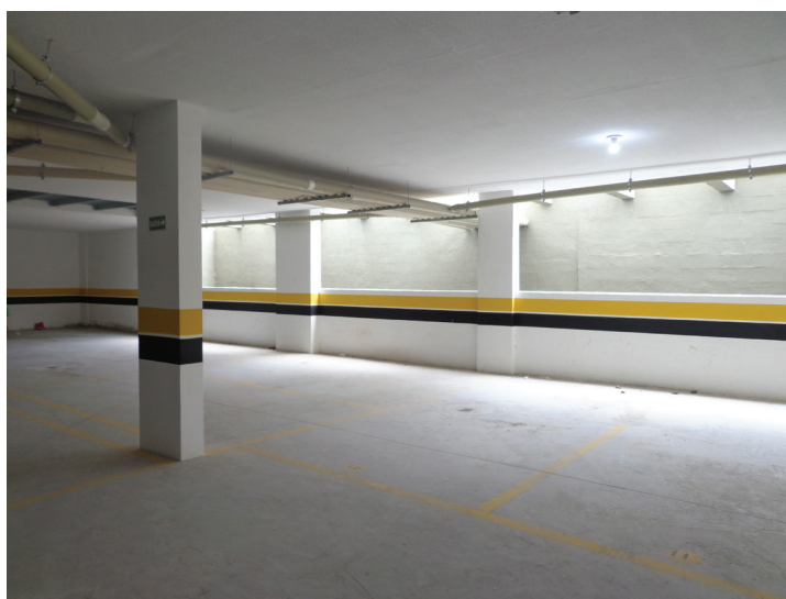
Figura 2 | Pilares e vigas em concreto no segundo pavimento
