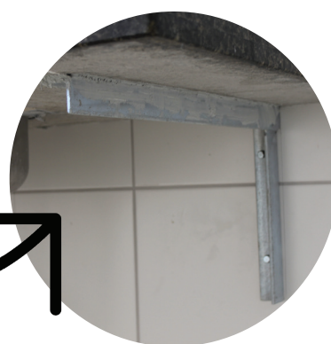
Figura 12 | Detalhe fixação da bancada
