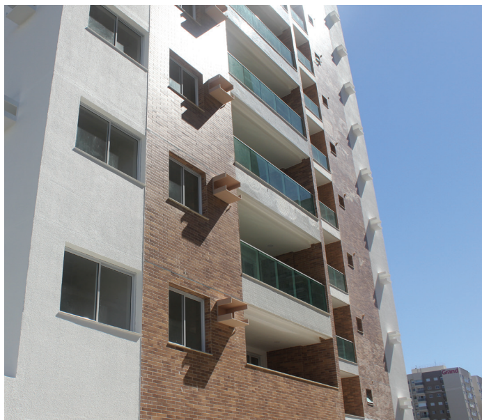
Figura 35 | Aplicação do vidro no guarda corpo na varanda e nas esquadrias
