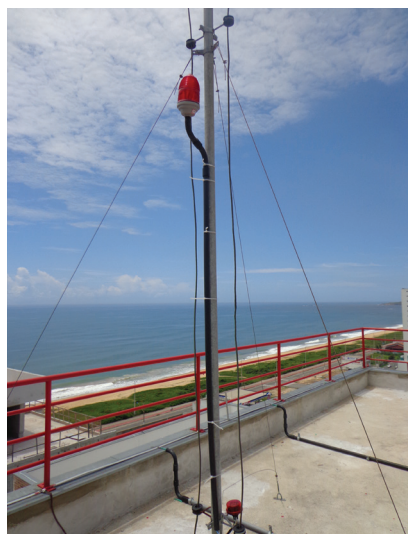
Figura 80 | Luz piloto no captador de SPDA
