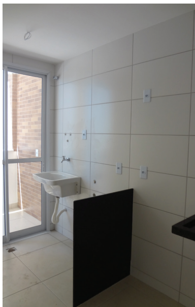
Figura 8 | Divisória na cozinha e área de serviço em granito
