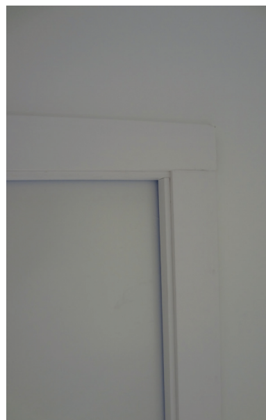
Figura 20 | Marco e alisar em madeira com acabamento em pintura branca
