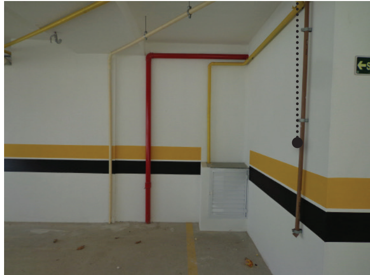
Figura 51 | Aviso do extravasor na garagem do pavimento lazer (pilotis) (próximo ao registro de gás)
