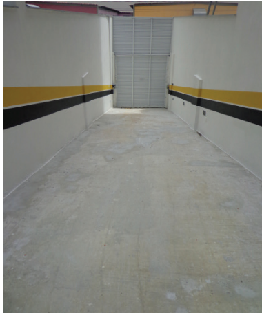
Figura 13 | Piso cimentício na rampa de acesso ao segundo pavimento (pilotis)
