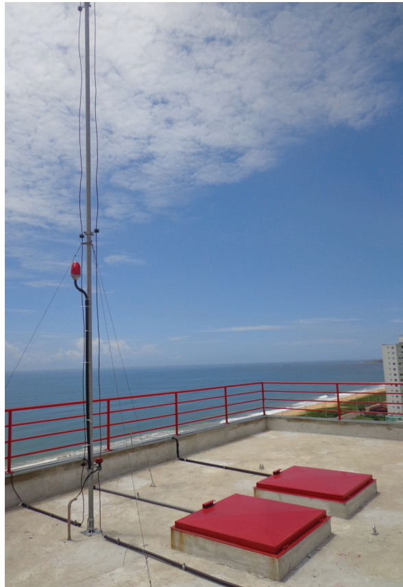
Figura 42 | Reservatório superior e tampas impermeabilizadas
