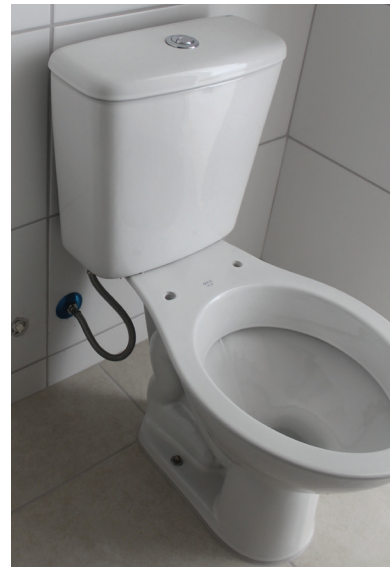
Figura 66 | Bacia sanitária com caixa acoplada nos banheiros
