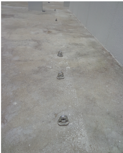
Figura 43 | Ganchos de ancoragem na laje do pavimento cobertura
