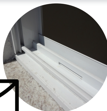
Figura 26 | Detalhe do dreno na janela
