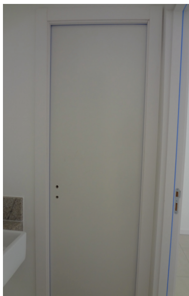
Figura 18 | Porta em madeira com acabamento em pintura branca
