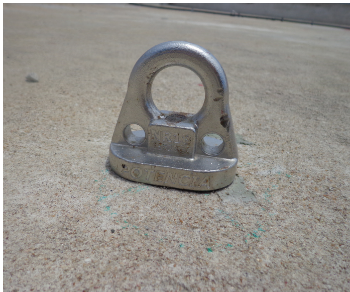
Figura 44 | Detalhe do gancho de ancoragem
