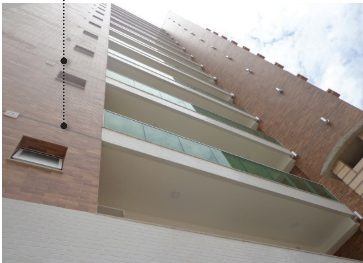
Figura 17 | Juntas de dilatação na fachada do edifício
