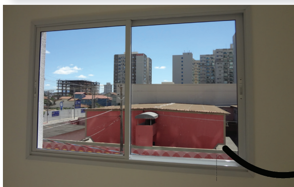
Figura 25 | Janela em esquadria de alumínio
