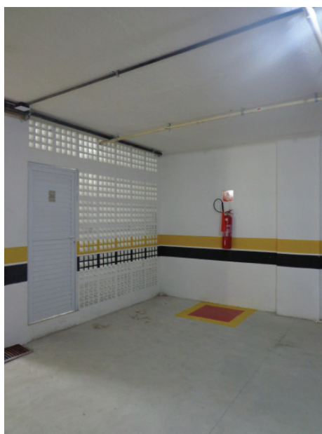
Figura 45 | Acesso a cisterna na garagem do subsolo
