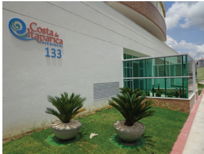
Figura 62 | Caixas de inspeção e gordura frontal à edificação
