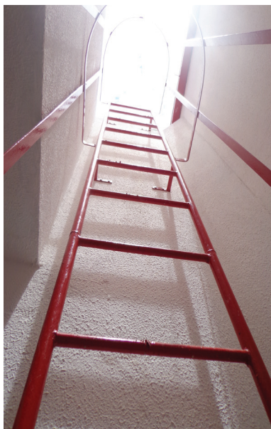
Figura 28 | Escada marinheiro de acesso ao reservatório superior
